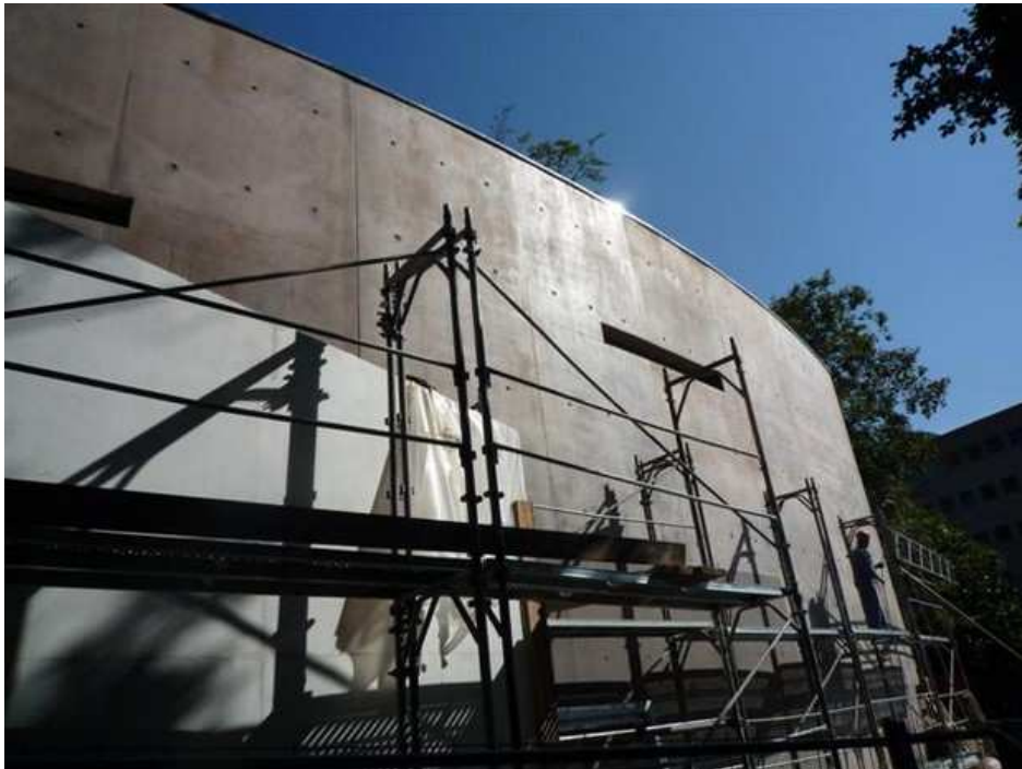
Bau der neuen Synagoge der GIL, Genf 30.09.09
