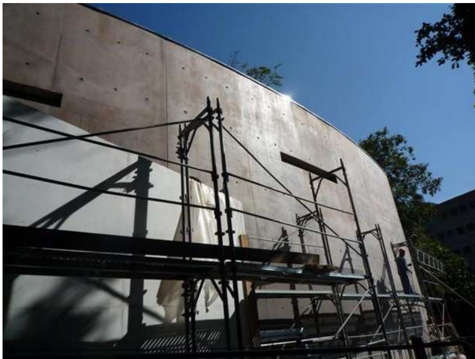
Construction de la nouvelle synagogue de la GIL, Genève 30/09/09
